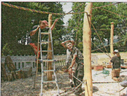
Das Anlegen des Seilgartens ist der umfangreichste Teil beim Arbeitseinsatz für den neuen Schulhof.
