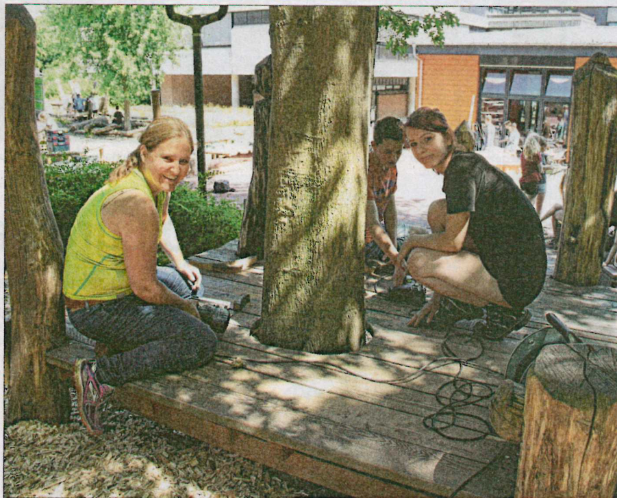
Bäume sollen ihren geschützten Lebensraum behalten. Dafür sorgen Stefanie, Samuel und Lena (von links) mit Holzplattformen um die Stämme.
